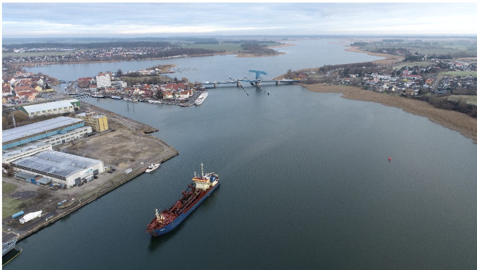
Baggerarbeiten Teil 1 Winter 2021 Foto: WSA Ostsee (nur für Presseabdruck)
