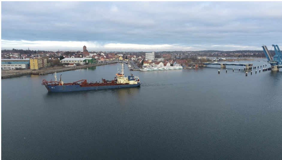
Baggerarbeiten Teil 1 Winter 2021
