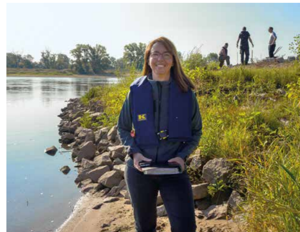
Uferbefestigung und Regelungssysteme an der Elbe – Kati Erlecke, Leiterin des Außenbezirks Tangermünde auf Inspektion
