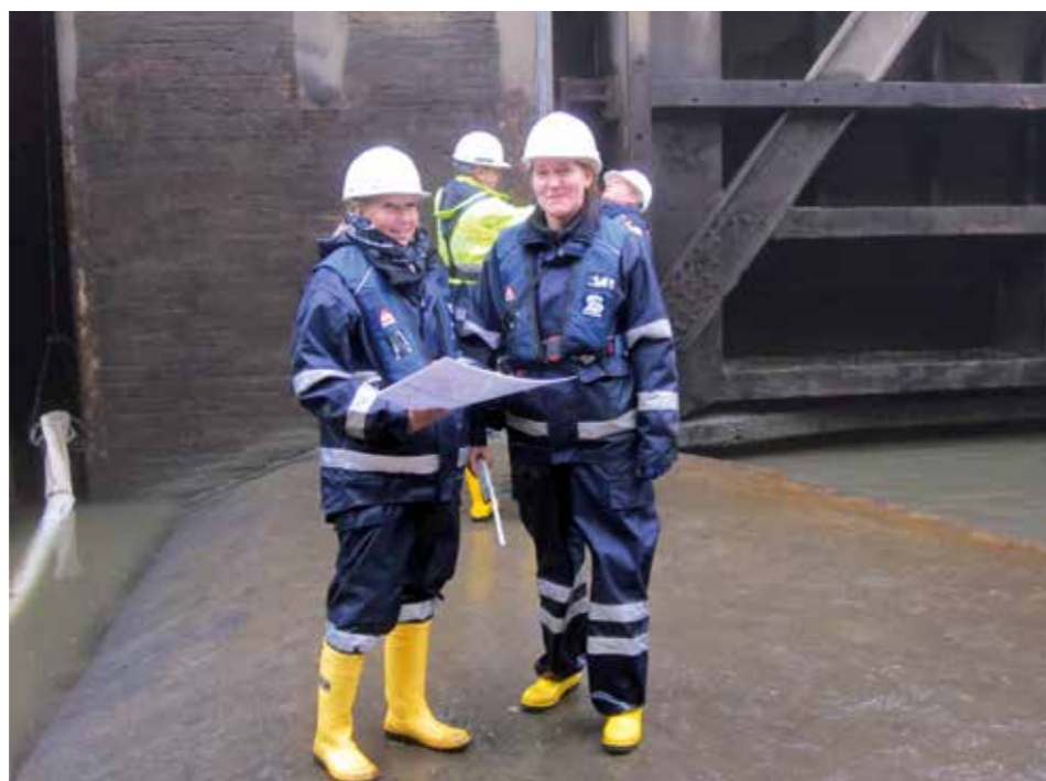
Im trockengelegten Inneren Este Sperrwerk in Hamburg Cranz – die Bauingenieurin Caroline Feldmann (rechts) und die Bautechnikerin Dany Kasprzak (links) vom Wasserstraßen- und Schifffahrtsamt Hamburg bei der Bauwerksinspektion
