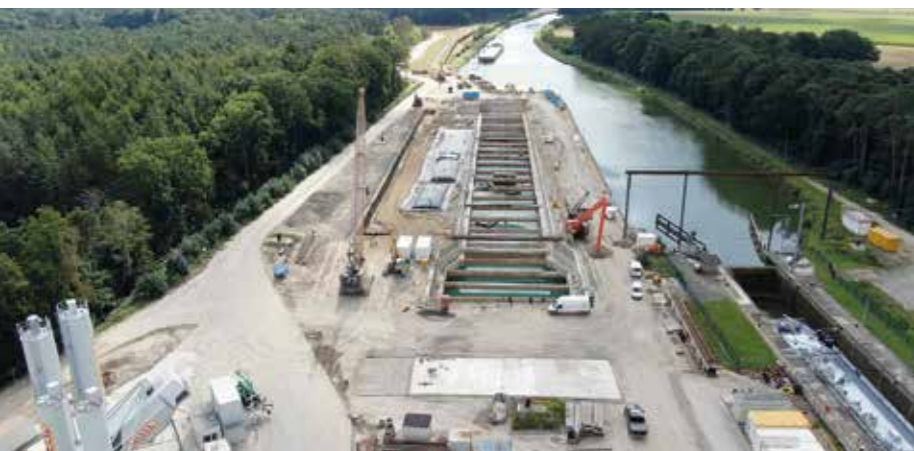
Baustelle am 4. August 2020
