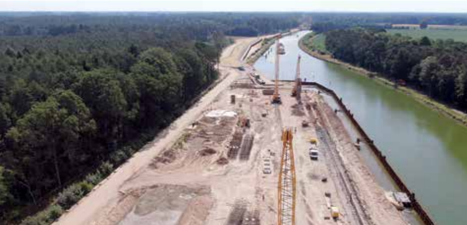
Baustelle am 25. Juni 2019
