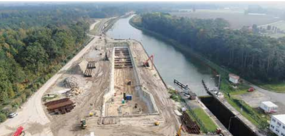
Baustelle am 23. Oktober 2019
